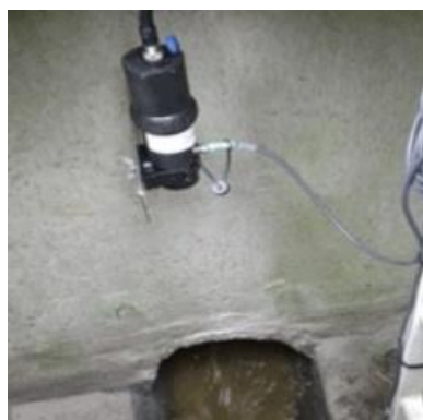
Medidor de nivel en arqueta
