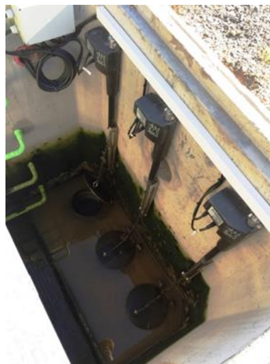
Arqueta con clapetas y actuadores
